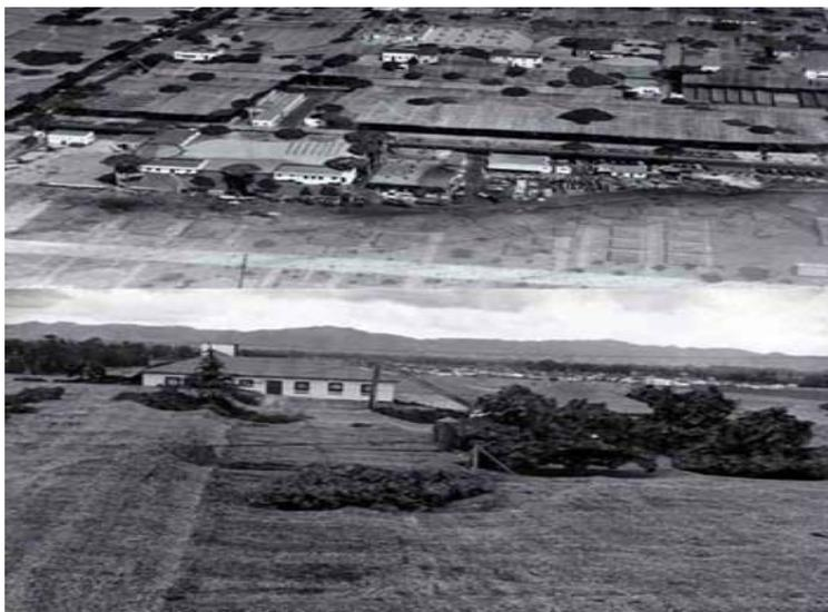
Рис. 1.10. Скрытие авиастроительного завода
