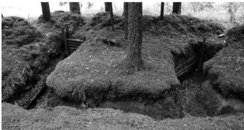
На фото сверху пример близкого к идеальному строительства окопов. Почти в полный профиль, под прикрытием крон деревьев, короткие изгибы. Добавить к этому «лисий норы» у каждой стрелковой ячейки и сделать перекрытия над траншеями из сетки-рабицы или крепких брёвен.
