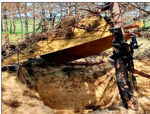
Рис. 6. Индивидуальный окоп с накидкой сверху, замаскированной хвойными ветками из окружающего леса
