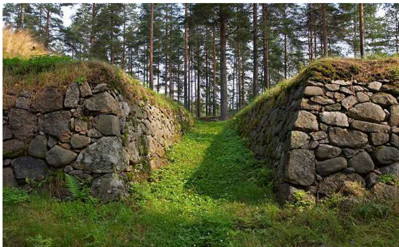
Рис. 1.6. Одежда крутостей из натурального камня времен Великой Отечественной войны
