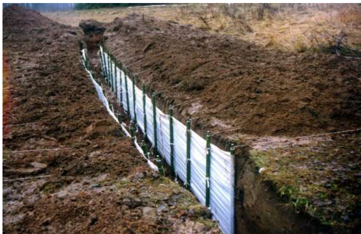
Рис. 1.7. Одежда крутостей из табельного комплекта
