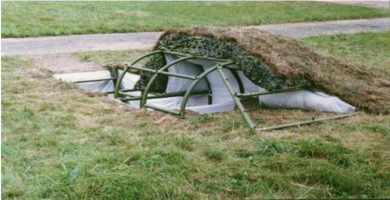
Рис. 1.4. Защитные устройства (противоосколочный козырек)
