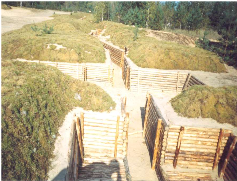
Рис. 1.5. Одежда крутостей из лесоматериала
